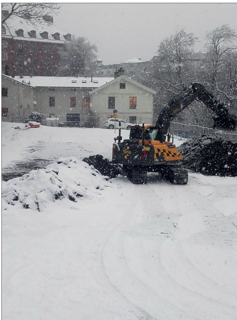
Figur 21. Delar av undersökningen gjordes med rejält vinterväder. Foto: Christina Rosén.
