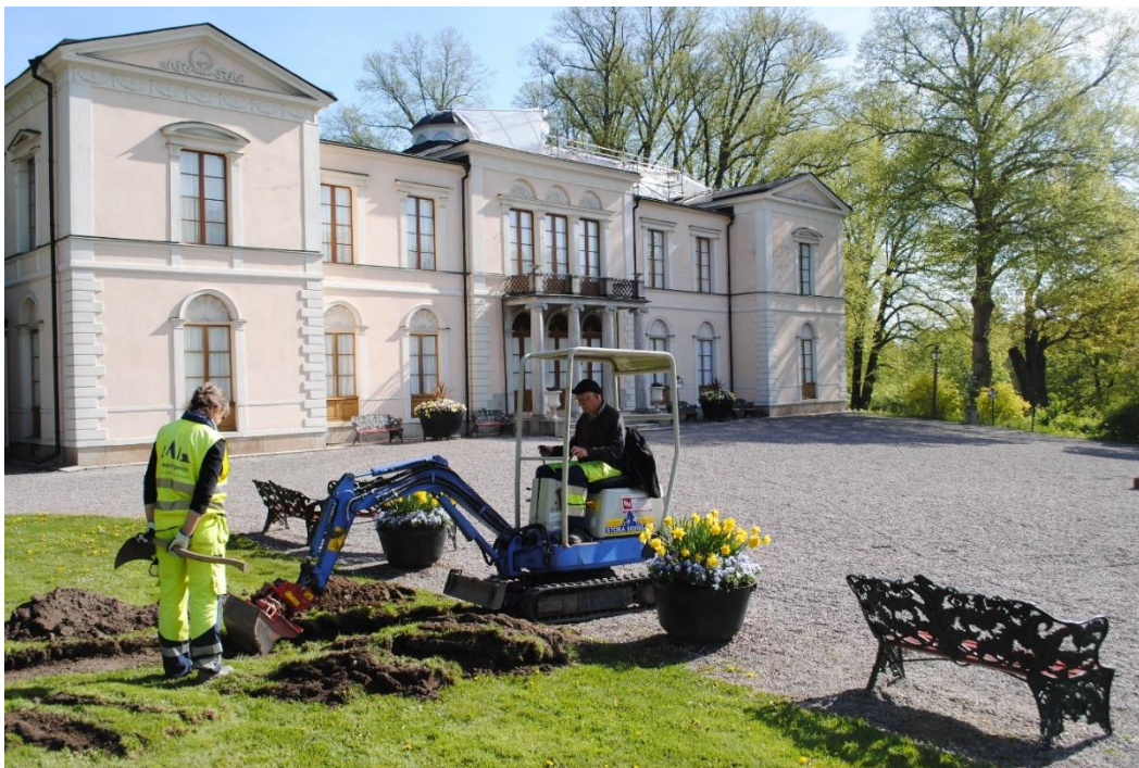
Figur 13 Ann-Mari Hållans Stenholm och Ulf Andersson tar upp ett schakt i dagens gårdsplan och i den intilliggande gräsytan framför slottsbyggnaden. Undersökningen visade att den äldre gårdsplanen har varit betydligt större än dagens. Foto: Arkeologerna.
