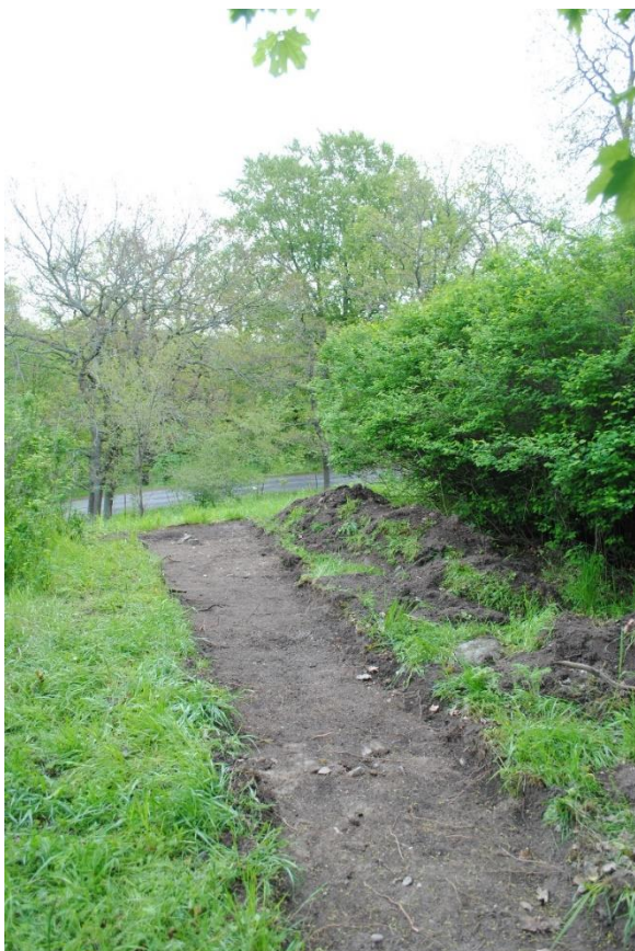
Figur 18 I Rosendalsbacken togs ett schakt upp på den högt belägna sittplatsen. Den plana ytan var belagd med småsten och fläckar av gul lera. På denna yta har sedan en 2,45 meter bred gångväg lagts ut. Utanför gångvägen, i kanten av den plana ytan, har det funnits en plantering. Foto: Arkeologerna.
