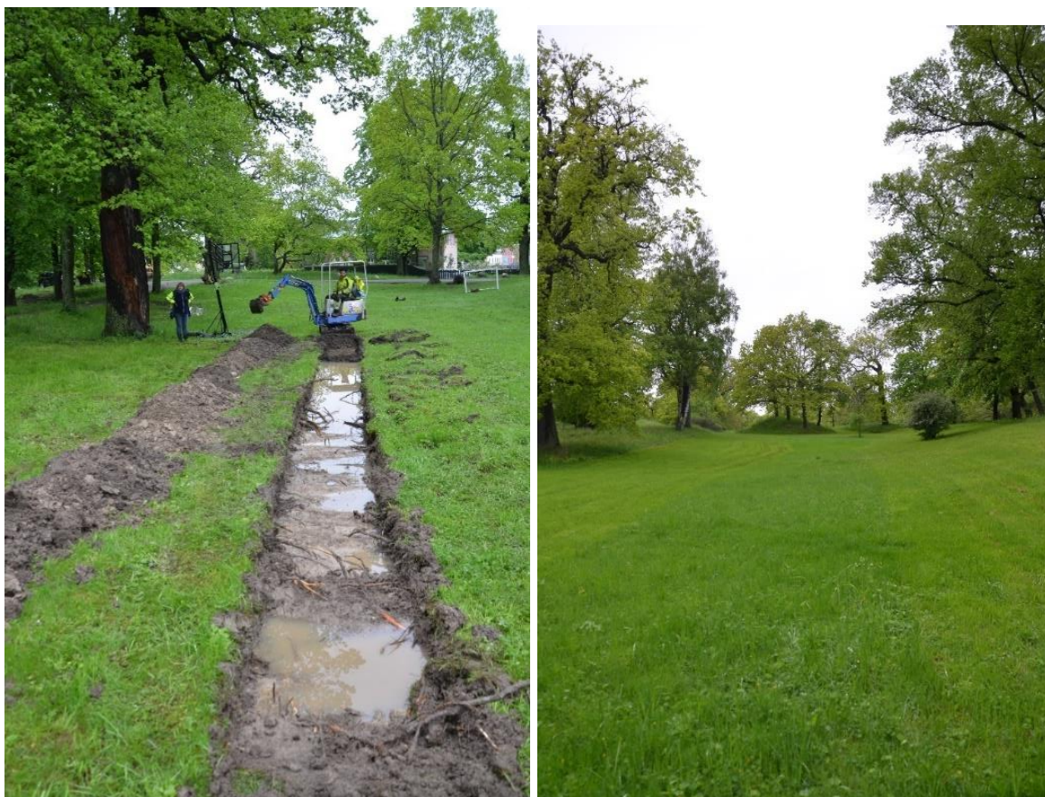
Figur 13 På bilden till vänster synd det schakt togs upp i pelousen i syfte att lokalisera det dike som enligt 1777 års karta, ledde vatten till dammen. I bakgrunden skymtar Kvikkjokk. Fotot är taget mot söder. Till höger syns pelousen mot norr. Längst bak i bild skymtar den uppbyggda kullen, som det enligt 1794 har stått en obelisk (?) på. Foto: Karin Lindeblad, Arkeologerna.
