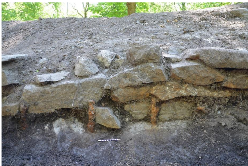
Figur 14. På tre ställen i dammen hölls stödmuren på plats av dobbbar i järn, som fästs i berget. Bilden visar dobbarna i dammens södra sida vid partiet med berg i dagen. Foto från nordväst: Karin Lindeblad, Arkeologerna.
