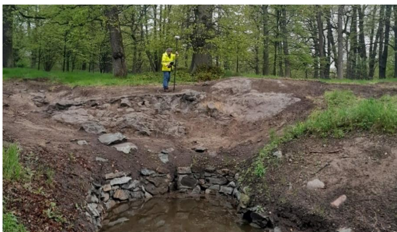
Figur 16. Ann-Mari Hållans Stenholm mäter in berghällen vid kanalens inlopp i maj 2023. Framför henne syns ett delvis sprängt bergsparti och inloppet i dammens stödmur. Den stensatta kanalen (SS2001) anas som en diagonal till vänster i bild. Foto från sydost.
