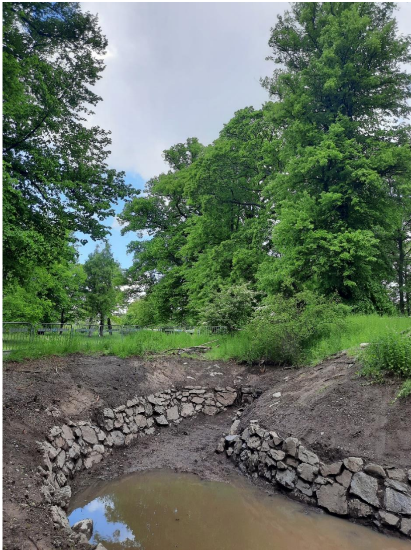
Figur 12. Västra delen av dammens stödmur i början av juni 2022. Foto från sydväst.
