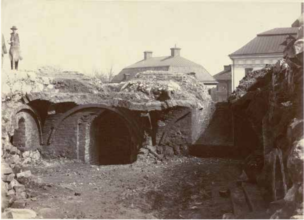
▲ Det finns flera foton som visar murarna efter ärkebiskopsborgen i Uppsala. Här syns ett källarrum med tegelvalv. Foto: alvin-record:94987 (alvin.se) .
