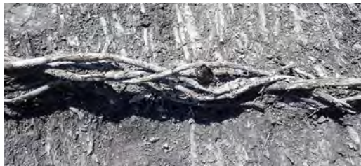
▲ Detalj av flätverk i vallens grundläggning från vallfas 2.
